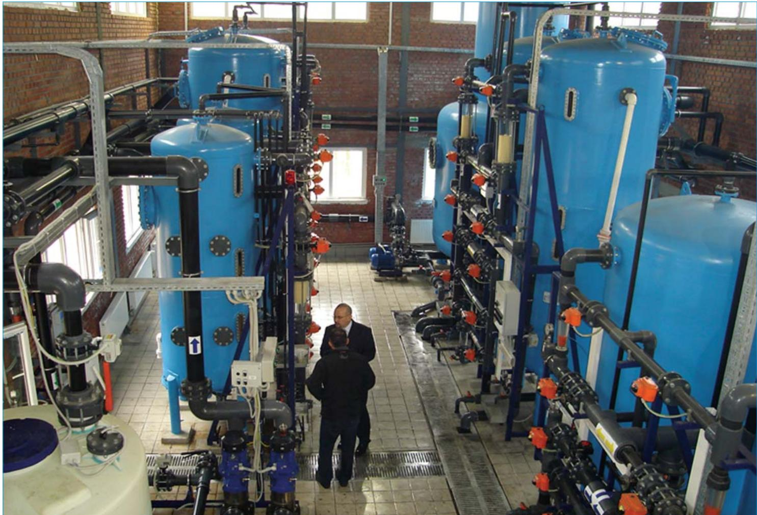
İşlem görmemiş tüm sularda, çözülmüş mineral tuzları bulunur. Bu tuzlar su içerisinde, pozitif yüklü katyonlara ve negatif yüklü anyonlara ayrılırlar. Deiyonizasyon Sistemi sayesinde bu iyonların miktarı çok düşük seviyelere indirilerek saflaştırma işlemi yapılır.
